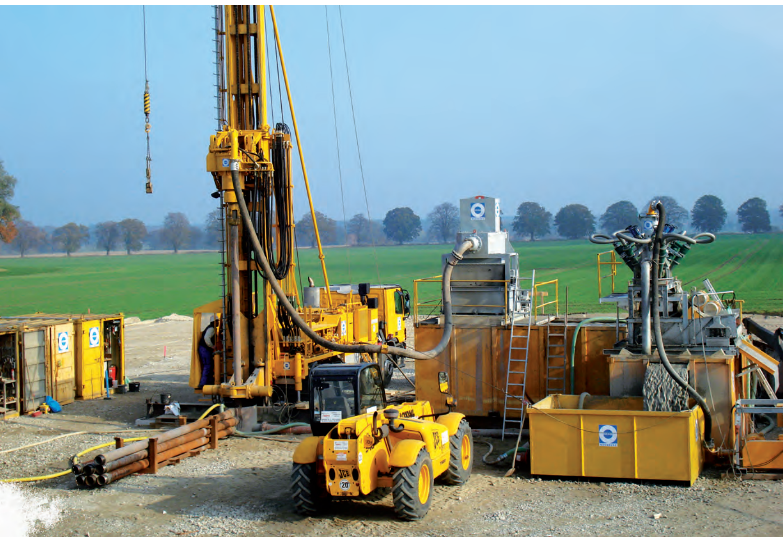
Lufthebohrung mit Spülsauberung
