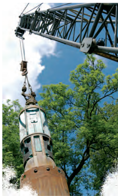
Bohrarbeiten mit Greifer
