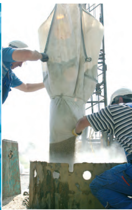
Einbau von Quarzkies
