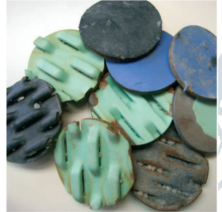
Herausgeschnittene Teile von schadhaften Brunnenrohren
