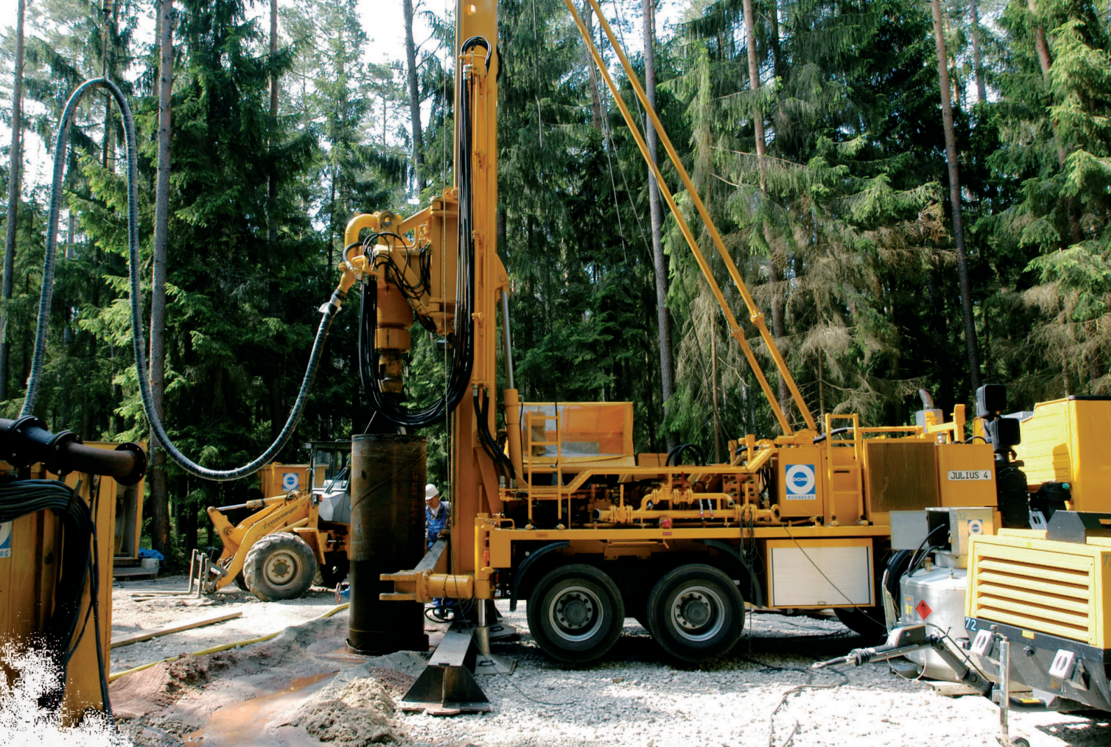
Überbohren von Sperrrohren
