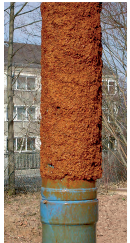
Verockerung von außen im Kies
