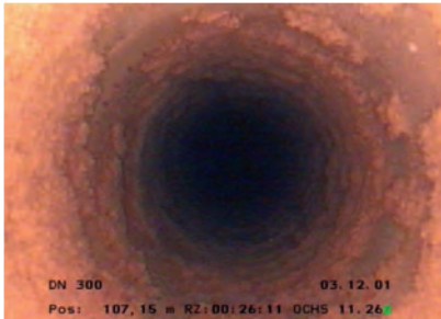
Lockere Verockerung mit Eisenhydroxiden
